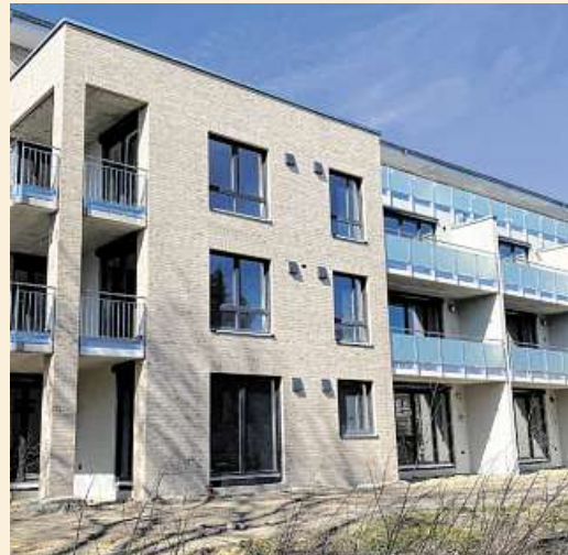
Das große und nach KfW-55-Standard errichtete Haus mit insgesamt 21 Wohneinheiten in Brokhuchting steht kurz vor der Fertigstellung.
