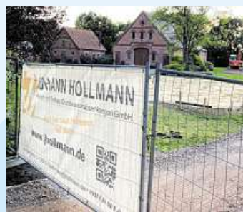
Im Tempelweg in Varrel entsteht zurzeit ein weiteres Prestigeobjekt der Stuhrer Firma.
