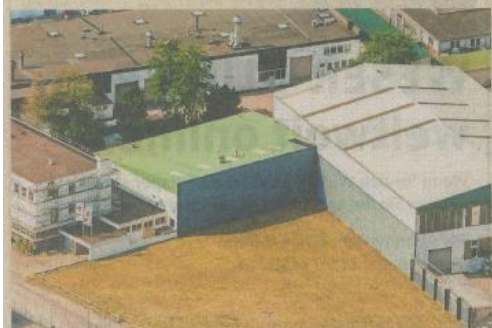
Am neuen Firmensitz an der Straße „An der Bahn“ in Moordeich sind Büro und Bauhof zusammengelegt
