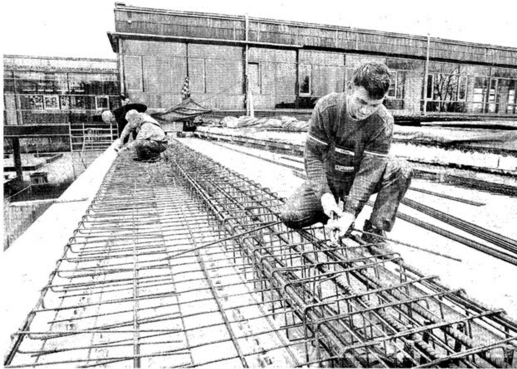
Die Arbeiten schreiten gut voran: Auf dem Dach der neuen Mensa der Lise-Meitner Schule wird gewerkelt, was das Zeug hält. Dort entsteht ein neues Stockwerk, in dem unter anderem neue Klassenräume untergebracht werden.
